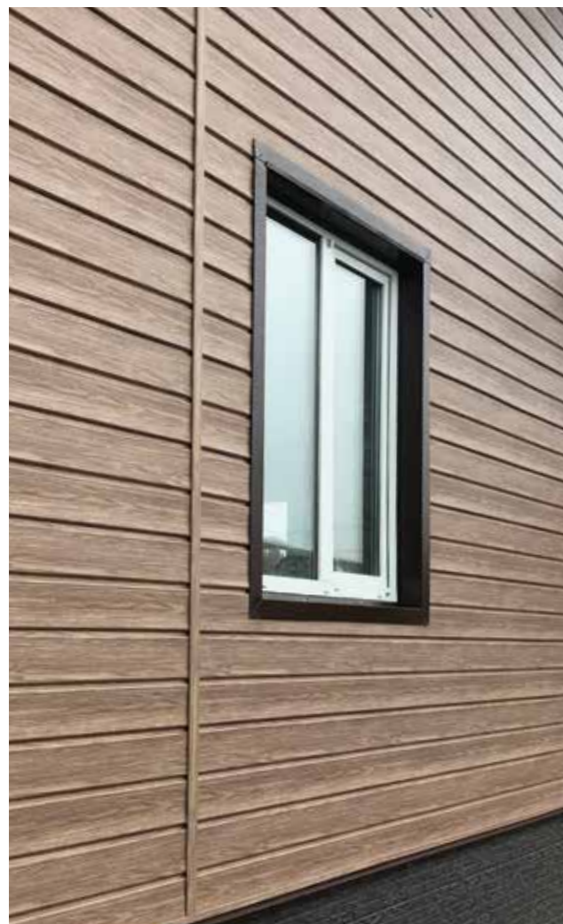
Пример монтажа сайдинга серии LUX под дерево
